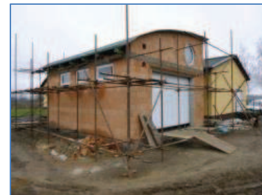
ČOV Medlov – architektonicky řešené zastřešení lapáku písku ve výstavbě
