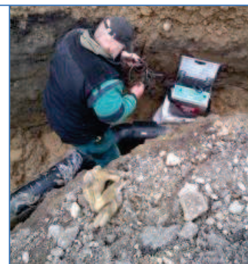
Přeložka vodovodu v Pňovicích vyvolaná snížením nívelítou opravované vozovky
