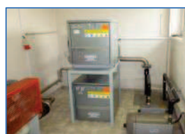
Dmychárna před a po výměně
