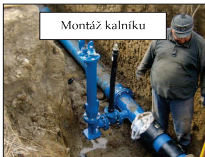
Pokládání vodovodu v trase
