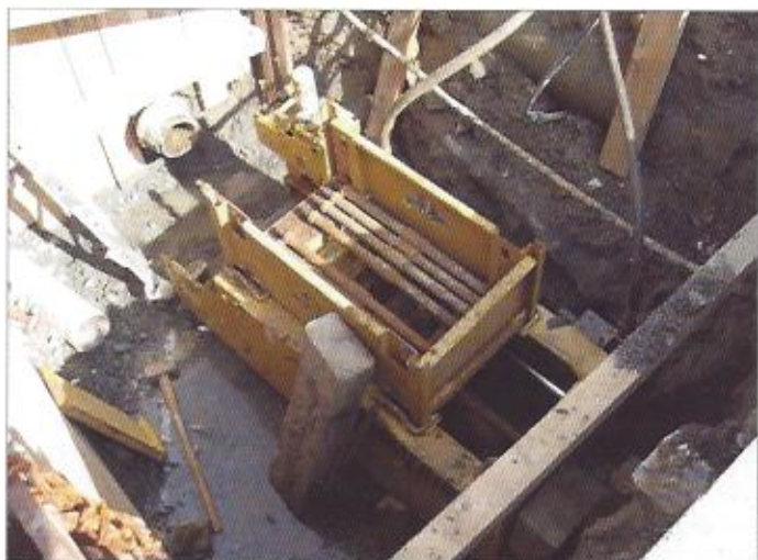
Koncová jáma s tažným zařízením, stavba Litovel
