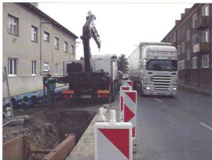
Pokládka potrubí za plného provozu, stavba Litovel
