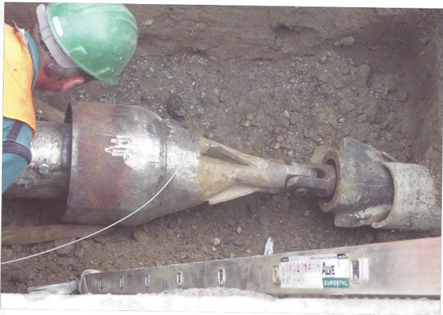
Trhací hlavice zajíždí a rozbíjí stávající potrubí z šedé litiny, dále následuje rozšiřovací hlavice s potrubím, stavba Litovel
