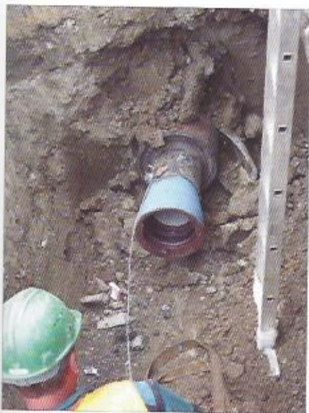
Montáž potrubí, stavba Litovel
