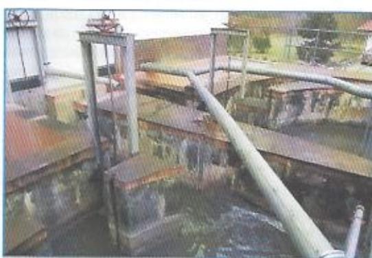
Voda zbavená největších nečistot pokračuje do virového lapáku písku. (Na ČOV jsou dva.) Tady se, jak název napovídá, odstraňuje z vody písek, škvára atp. Lapák využívá odstředivých sil, díky kterým písek klesá ke dnu a je odsát čerpadlem zvaným mamutka. Také on skončí na skládce.
