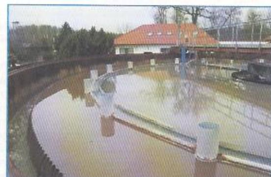
Voda je čerpána dál do usazovací nádrže. Tady zůstane 18 hodin, aby se mohly usadit nerozpustné látky. Ty tvoří tzv. primární kal. Stirací zařízení (v pravé části snímku), které v nádrži zvolna rotuje, odstraňuje usazený kal ze dna i plovoucí nečistoty z hladiny.
