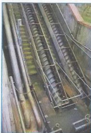
Systémem kanálů byla znečištěná voda přivedena z domácností a průmyslu až na čistírnu odpadních vod. Šneková čerpadla (vlevo) ji vytlačí nahoru do česlovny. Je to jediné místo, kde voda ještě zapáčhá, proto je v zastřešené budově. Úkolem česlí (kovový pás vpravo) je zachytit předměty
